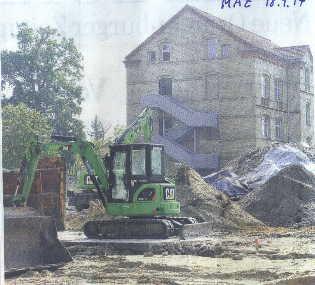
Nach den Abrissarbeiten auf dem Schulhof gibt es jetzt einen Baustopp.
