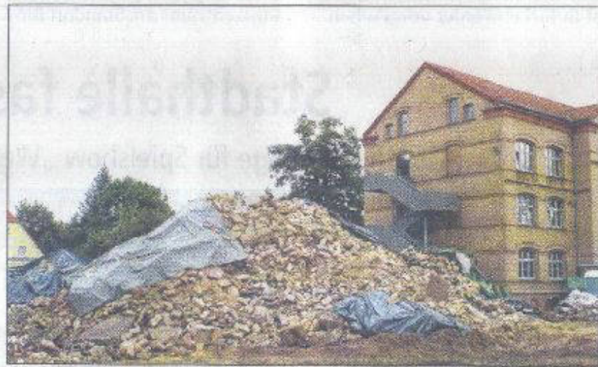
Platz wird schon geschaffen: Für den Neubau des Zentrums werden derzeit Nebengebäude der Schule abgerissen. Foto: Birte Förster
